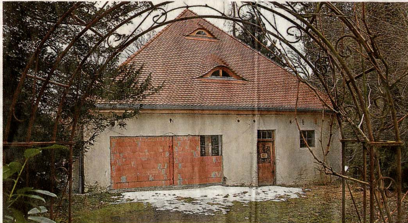
An der Nordseite der Remise sollte angebaut werden. Aus Gründen des Denkmalschutzes wird dies abgelehnt.
